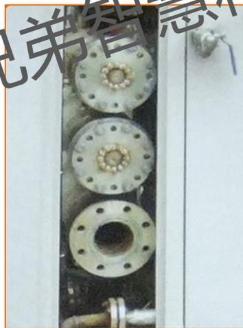
采用法兰式电热管/便于维修
